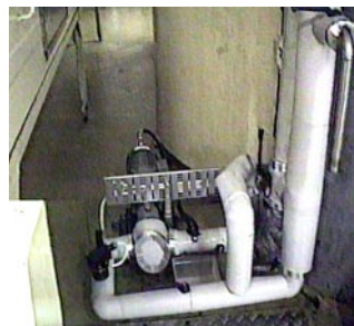
Den värmeisolerade lobrotorpumpen med sitt mantlade lock.
