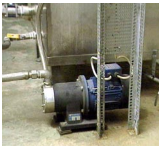
Magnetdriften kapslar in systemet helt och skyddar från eventuella föroreningar i omgivningen.
